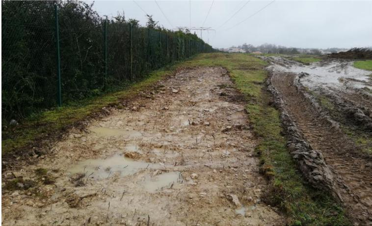
*Figure 7. Préparation de la zone receveuse par décapage des terres*
