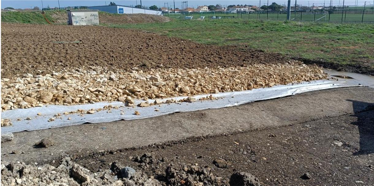
Figure 27. Couches successives constituées sur les dépôts de mâchefers
