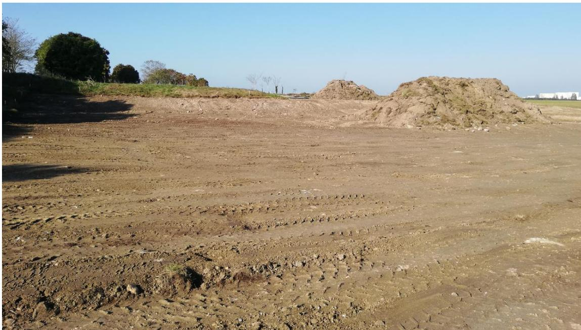
Figure 4. Zone receveuse décapée et avant régallage
