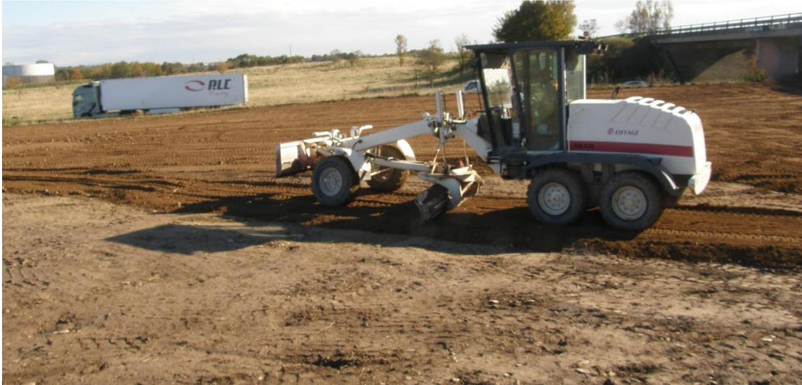
Figure 5. Régalage des terres sur la zone receveuse
