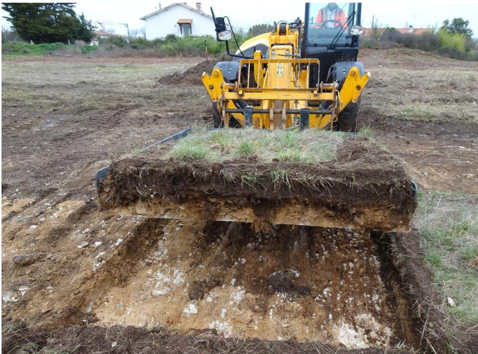
*Figure 20. Récupération des plaques de sol sur plaques métal préfabriquées et montées sur télescopiques*
