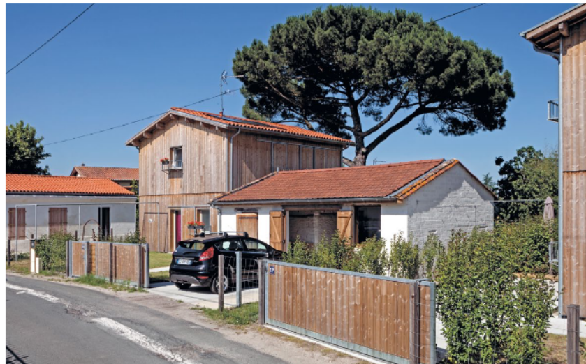
LA FERME LABONNE ET LA MAISON ROLDAN, BLANQUEFORT MOA : SEMI de Blanquefort MOE : Atelier Alexandre Chemetoff
