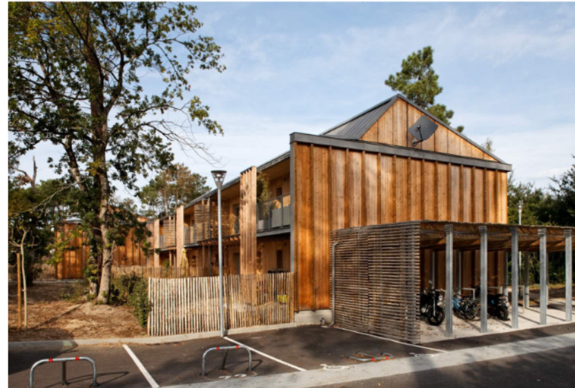
22 LOGEMENTS SOCIAUX, LA TESTE-DE-BUCH MOA : Le Foyer de la Gironde MOE : MCVD
